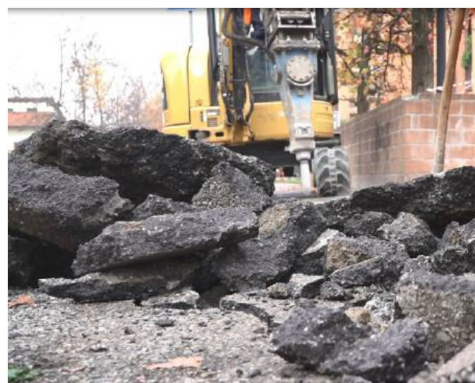
I lavori in fase di svolgimento da parte della società Planetel
